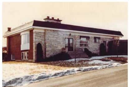
Maison rue Cate
